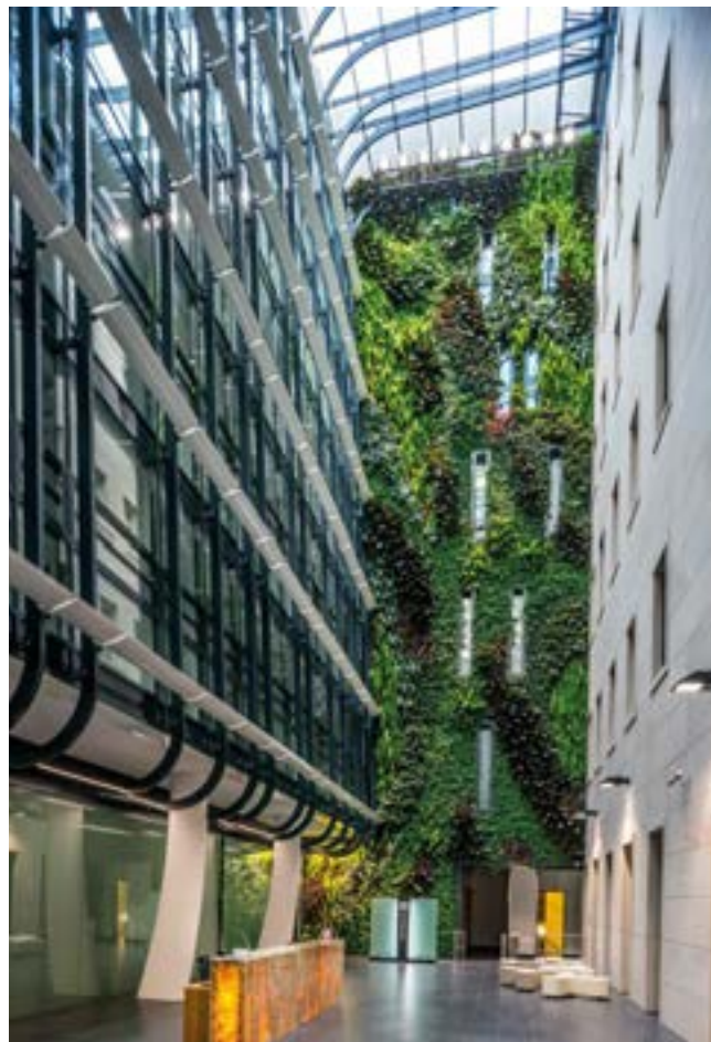
Atrium se zelenou stěnou – Jindřišská 16
