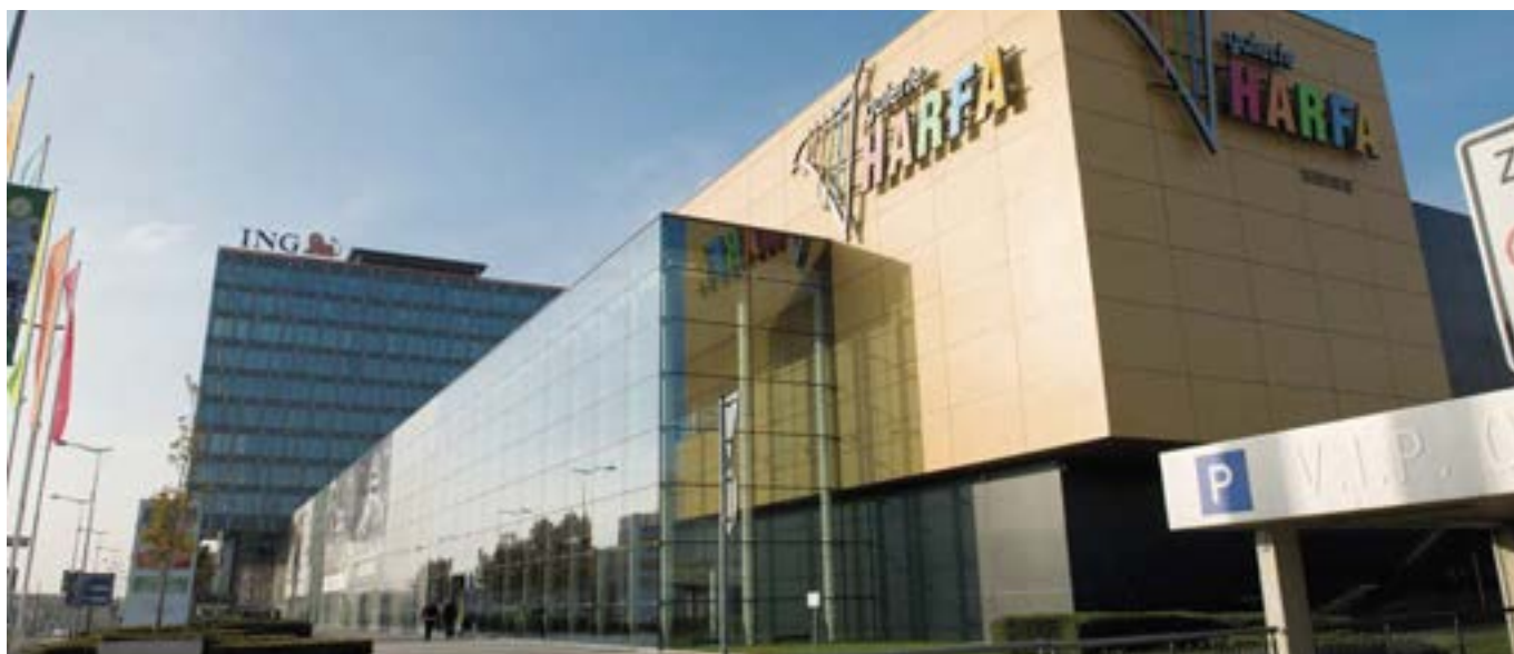
Obchodní a administrativní centrum Galerie Harfa letos získalo certifikát energetické a environmentální úspornosti LEED EB:OM Gold
